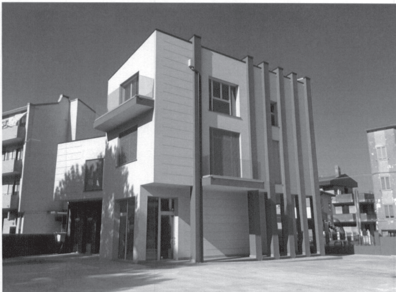
2013-2015 (progetto completato) – Ristrutturazione con ampliamento di edificio ad uso commerciale/produttivo
